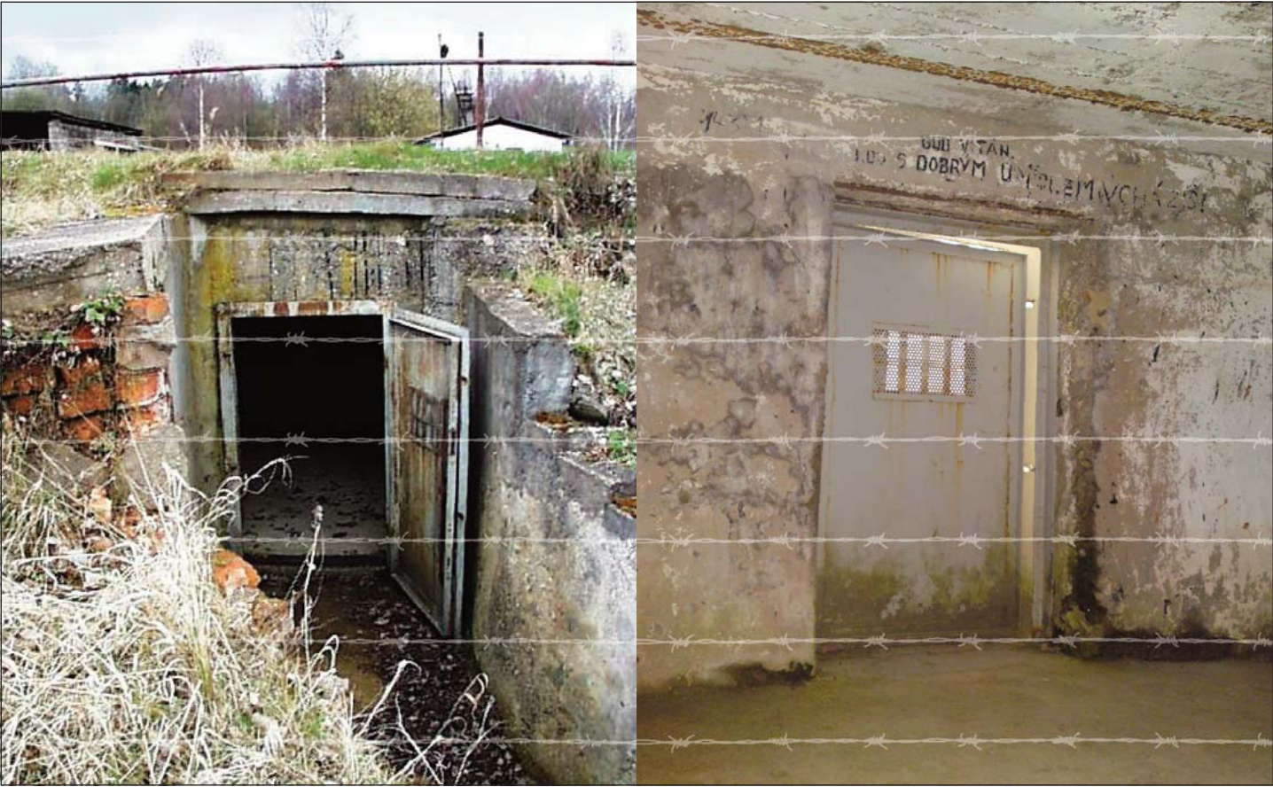
Původní vstup do bunkru
