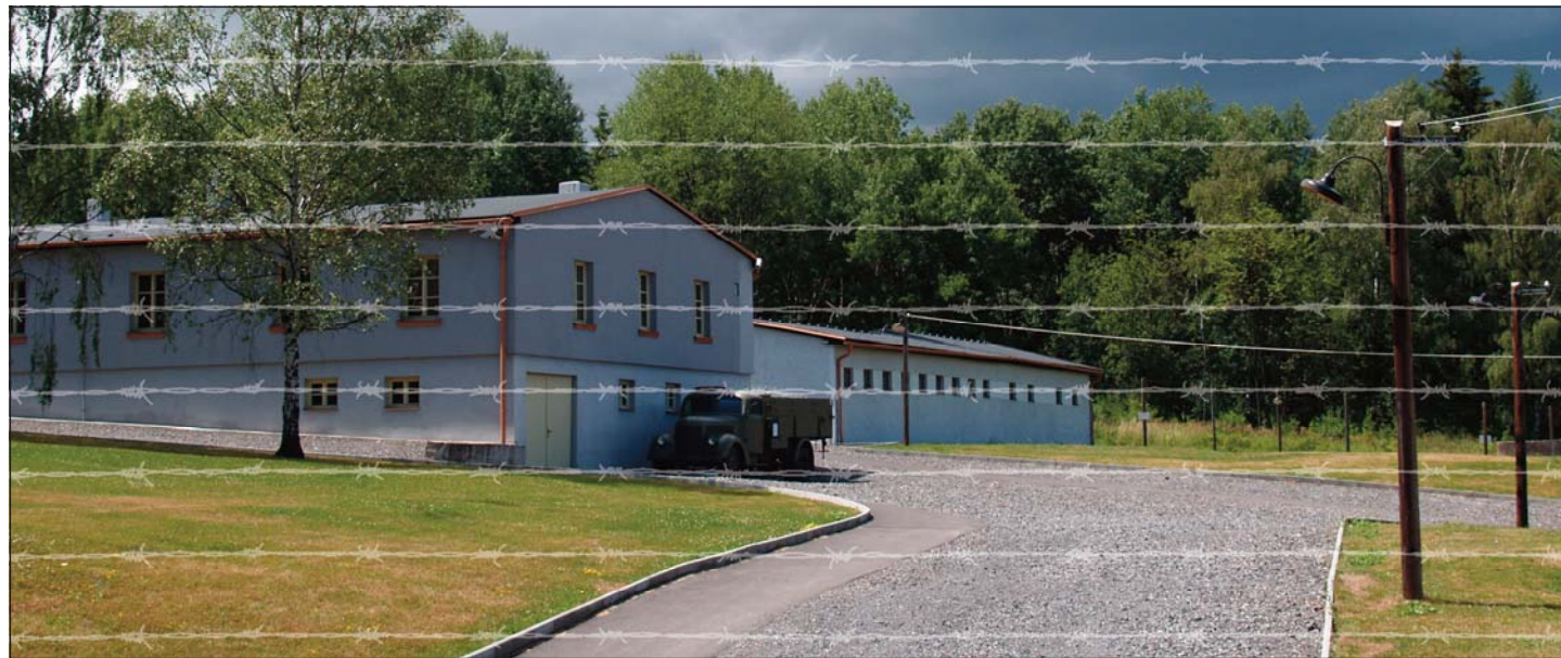
Pohled na budovu velitelství (v pozadí budova korekce).
