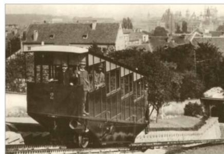
Vozy petřínské lanovky z roku 1891 vyrobila známá pražská firma Ringhoffer, s rozchodem 1 000 mm, uprostřed kolejí brzdící ozubnice, pohon s vodní převahou, s tažným lanem o průměru 35 mm (7 pramenů po 133 drátech).
